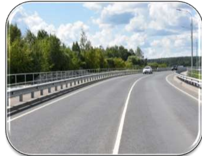
МОСТ ЧЕРЕЗ РЕКУ БОЛВА, РАСПОЛОЖЕННЫЙ НА АВТОДОРОГЕ «ПОДЪЕЗД К ГОРОДУ ФОКИНО»
