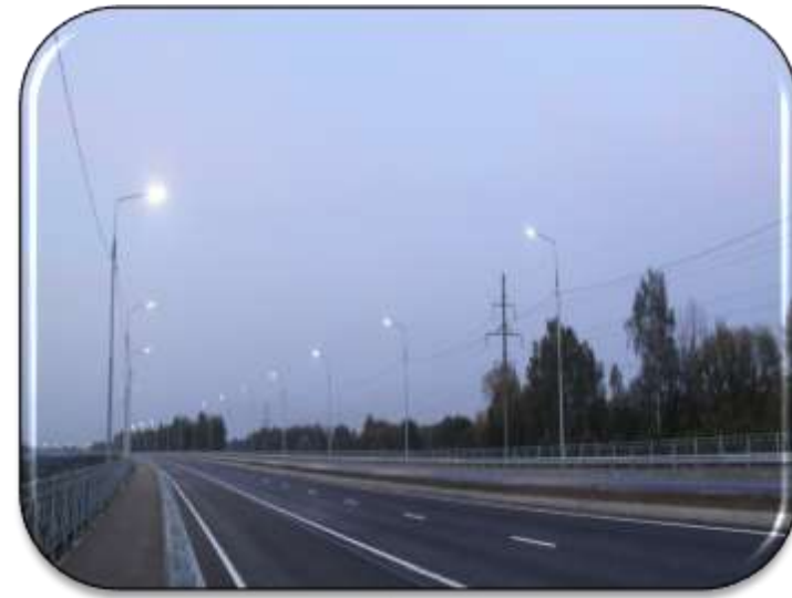
АВТОМОБИЛЬНАЯ ДОРОГА- ДАМБА БРЯНСК I – БРЯНСК II
